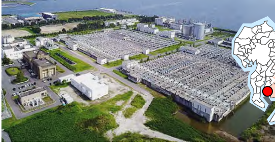
▲矢作川浄化センター(平成4年処理開始) 矢作川流域4市1町(岡崎市、豊田市、西尾市、幸田町)から集まる下水を処理しています
