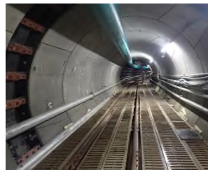
▲雨水管やポンプ場の内部 | 雨水管(左)は建設時の様子
