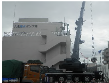
▲六名雨水ポンプ場 | 建設中の様子
