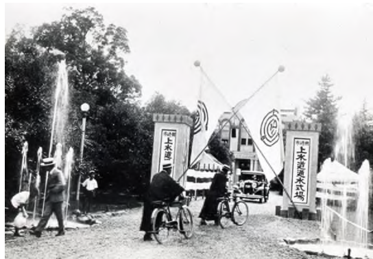
水道の通水式
