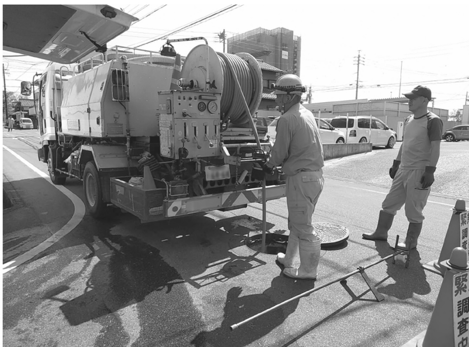
▲業務委託による管渠清掃作業の様子
