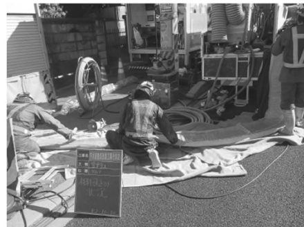
▲反転・形成工法（挿入状況）
