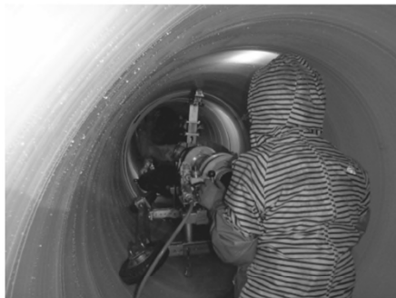
▲製管工法（製管作業状況）
