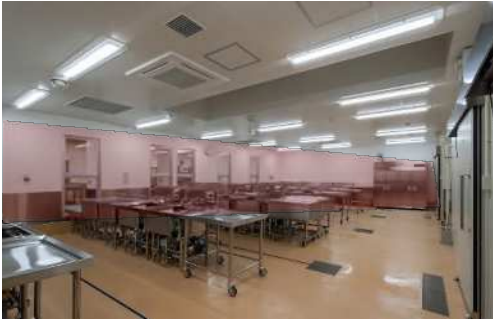
↑ 汚染作業区域（下処理スペース）を壁で区分け
