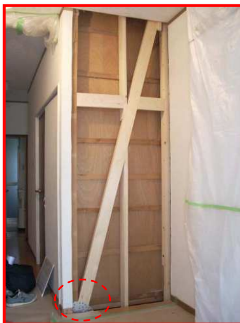
耐震改修の例（筋交い金物補強）
