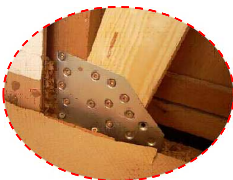
耐震改修の例（筋交い金物補強）
