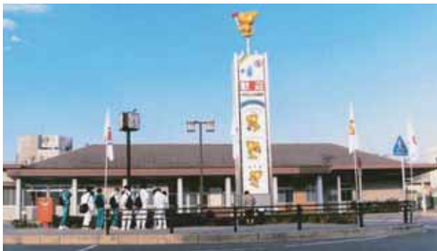
旧駅舎（平成6年頃）
