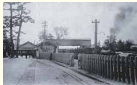
明治末期頃の岡崎駅 （駅開業は明治21年）
