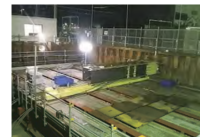
トンネル工事の様子
