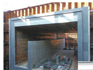
写真左にある擁壁は歩道と車道の界となる擁壁です。
