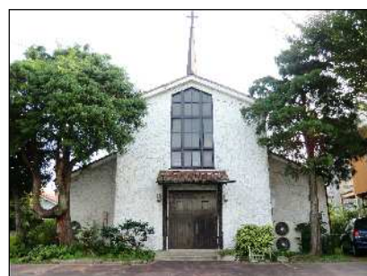
図1-7-48 日本福音ルーテル岡崎教会教会堂
