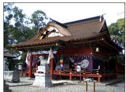
図1-7-20 伊賀八幡宮拝殿
