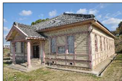
図1-7-46 旧愛知県第二尋常中学校講堂
