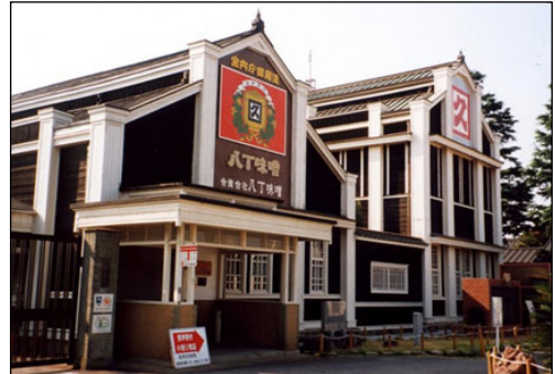
図4-17 カクキュー本社事務所
