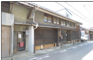
旧野村家住宅(米屋) 耐震補強工事
