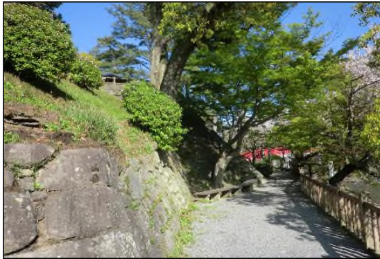
月見櫓台石垣樹木伐採前(令和2年4月)
