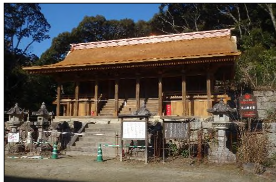
保存修理後:全解体修理
