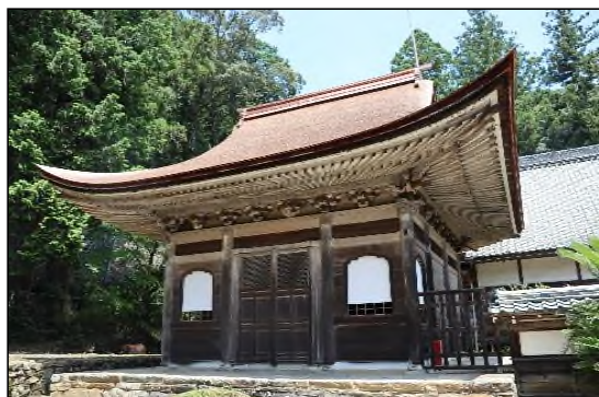
保存修理後:屋根葺替及び部分修理
