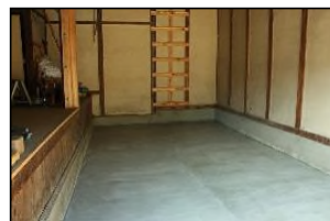
山車小屋土間の修繕
