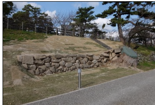
令和元年度整備
