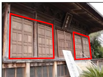
甲山寺(本堂)扉修繕工事
