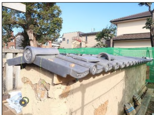
土塀瓦の葺替
