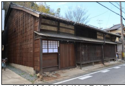
修景後(令和8(2026)年3月11日)
