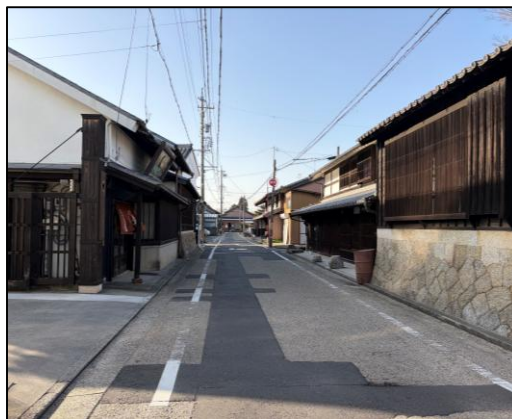
電線共同溝工事(管路整備)完了 ※令和8(2026)年度 道路美化化予定
