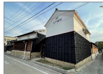
図2: 景観重要建造物 まるや八丁味噌土蔵(R4板壁修景後)
