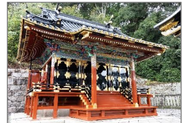
図2: 国指定重要文化財 滝山東照宮本殿(R3～7保存修理)
