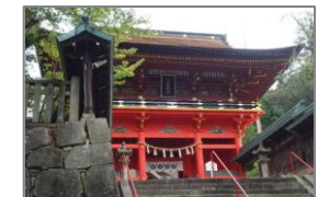
図2:六所神社社殿の塗替補修(H26～29)
