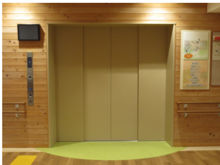
▲ 開口部の広い扉(間口:200cm) 内部の確認ができるモニター(左上)
