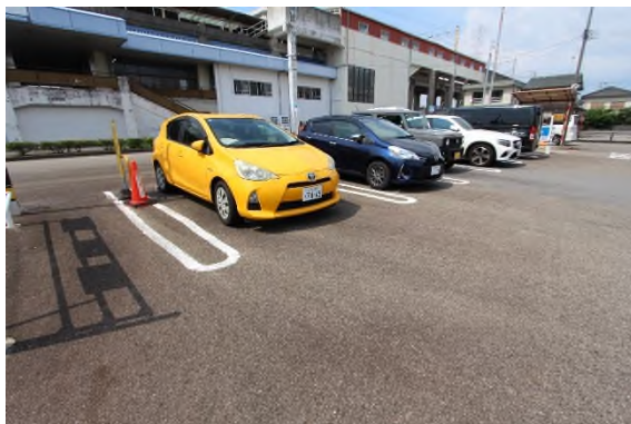
▲障がい者用駐車施設の表示がない
