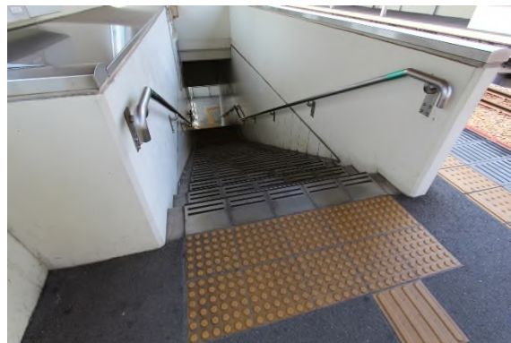
▲3階ホームから見た階段
