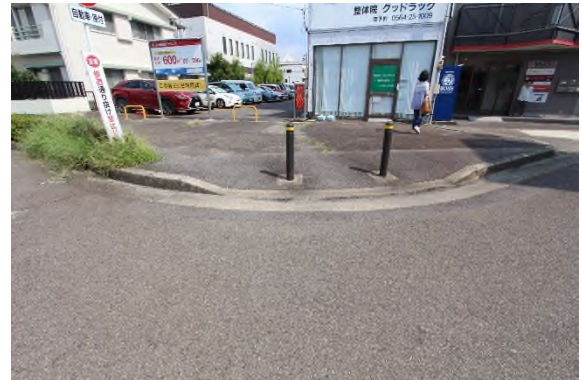
▲交差点部で急こう配の箇所
