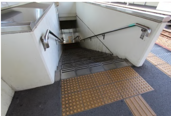
▲3階ホームから2階改札口への階段
