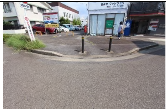
▲交差点部で急こう配の箇所
