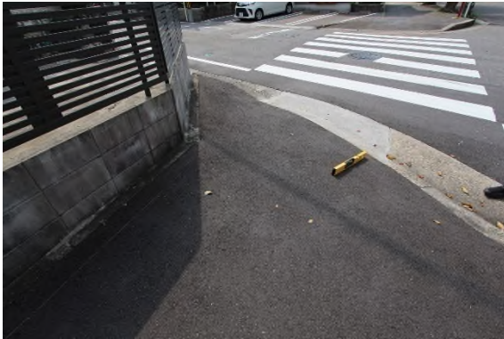
▲交差点部で急こう配の箇所
