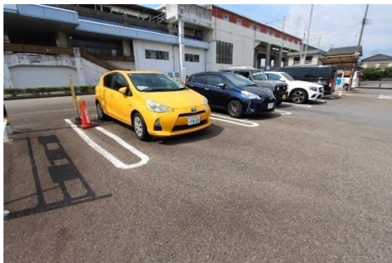
▲障がい者用駐車施設の表示がない
