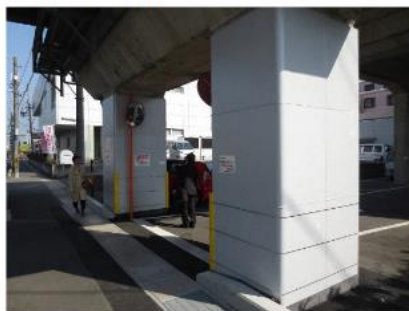
【橋脚の耐震補強】
