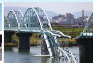
和歌山市水管橋崩落事故 (令和3年10月)
