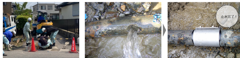
修繕工事の事例：口径100mmの鋼管に空いた穴の緊急修繕（令和3年 市内）
