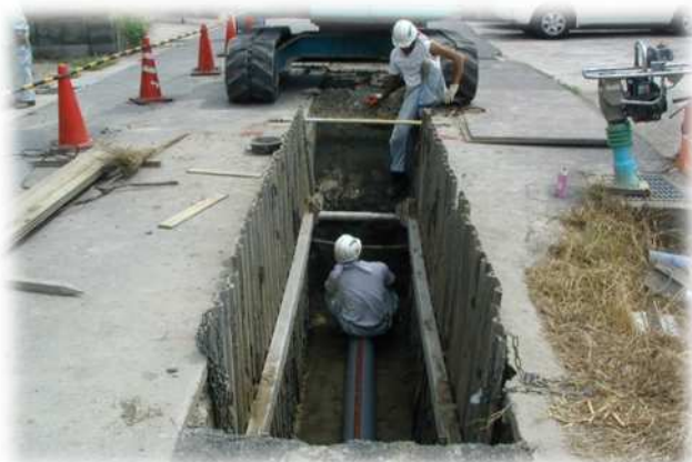
(下水道管工事の様子)
