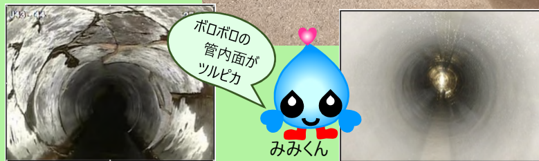
▲老朽化で内面がボロボロの下水道管 → 管更生(内面再生工法)
