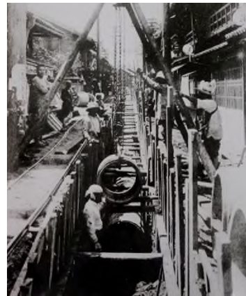
下水道工事の様子
