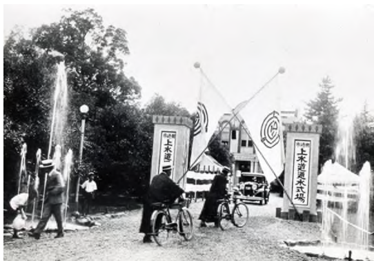
水道の通水式
