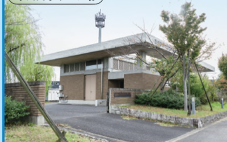
砂川雨水ポンプ場
