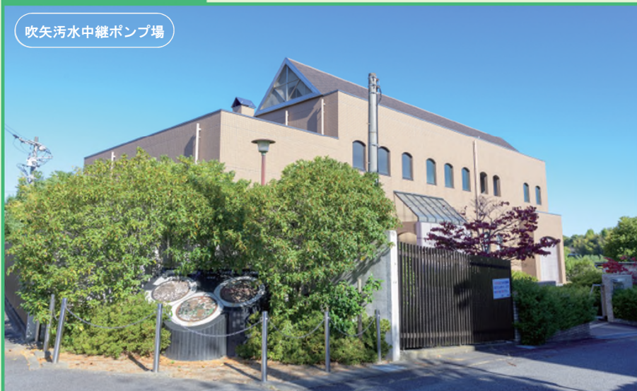
大西汚水中継ポンプ場
