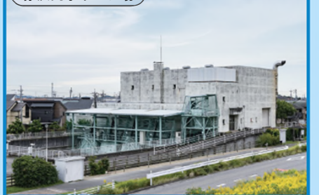
赤渋雨水ポンプ場
