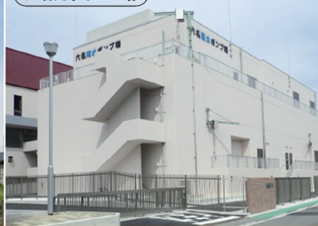
六名雨水ポンプ場
