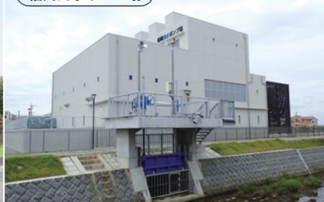
福岡雨水ポンプ場
