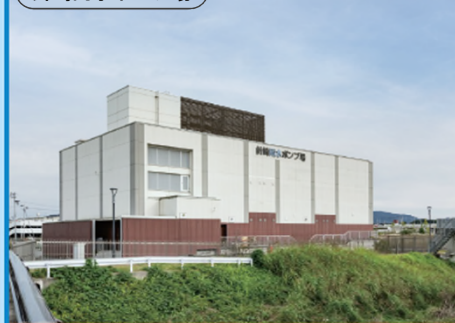
針崎雨水ポンプ場
