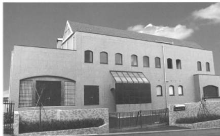
▲吹矢汚水中継ポンプ場
