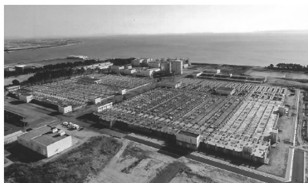
▲矢作川浄化センター
