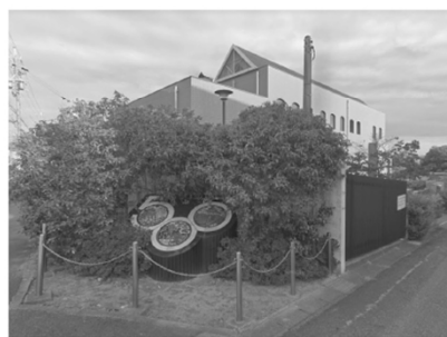
▲吹矢汚水中継ポンプ場
