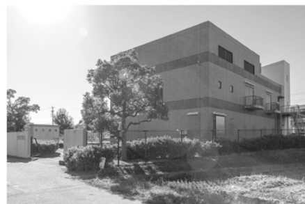
▲美合汚水中継ポンプ場
