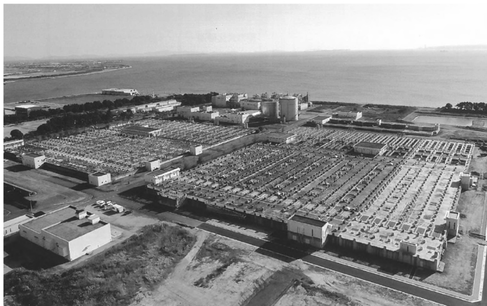
▲矢作川浄化センター
