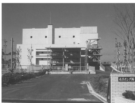
▲赤渋雨水ポンプ場
