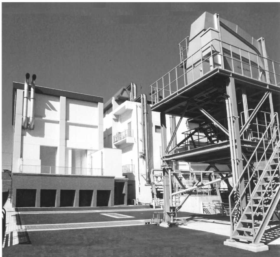
▲大門雨水ポンプ場
