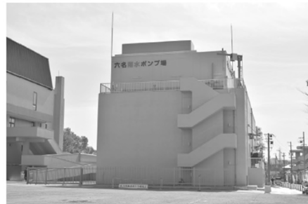
▲六名雨水ポンプ場
