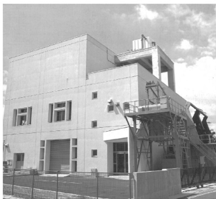
▲八帖雨水ポンプ場
