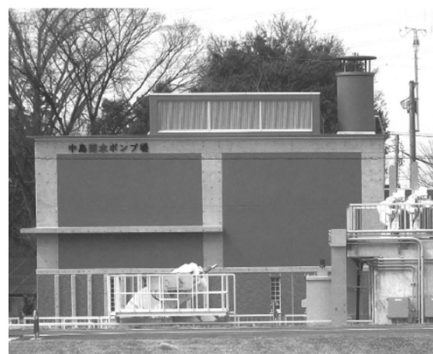
▲中島雨水ポンプ場
