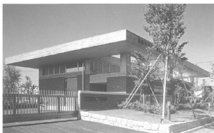
▲砂川雨水ポンプ場
