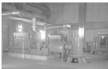
▲ポンプ用エンジン部
