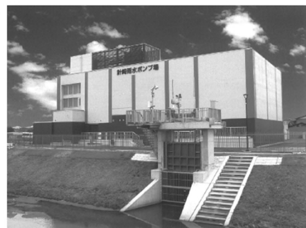
▲針崎雨水ポンプ場
