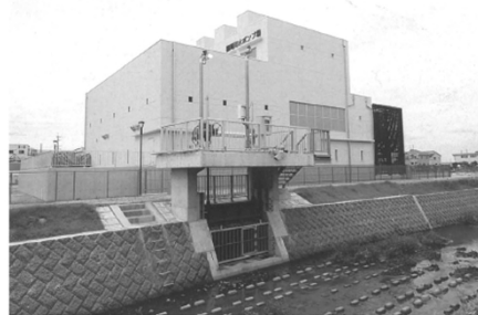
▲福岡雨水ポンプ場
