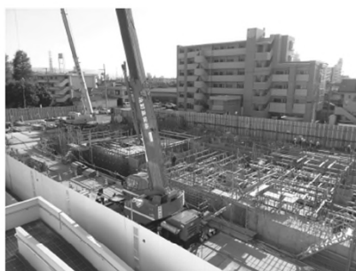
▲六名雨水ポンプ場
