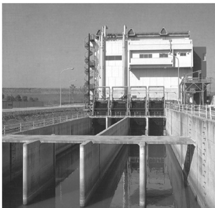
▲大門雨水ポンプ場
