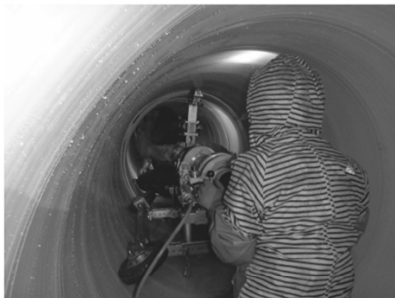
▲製管工法（製管作業状況）
