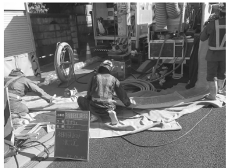
▲反転・形成工法（挿入状況）
