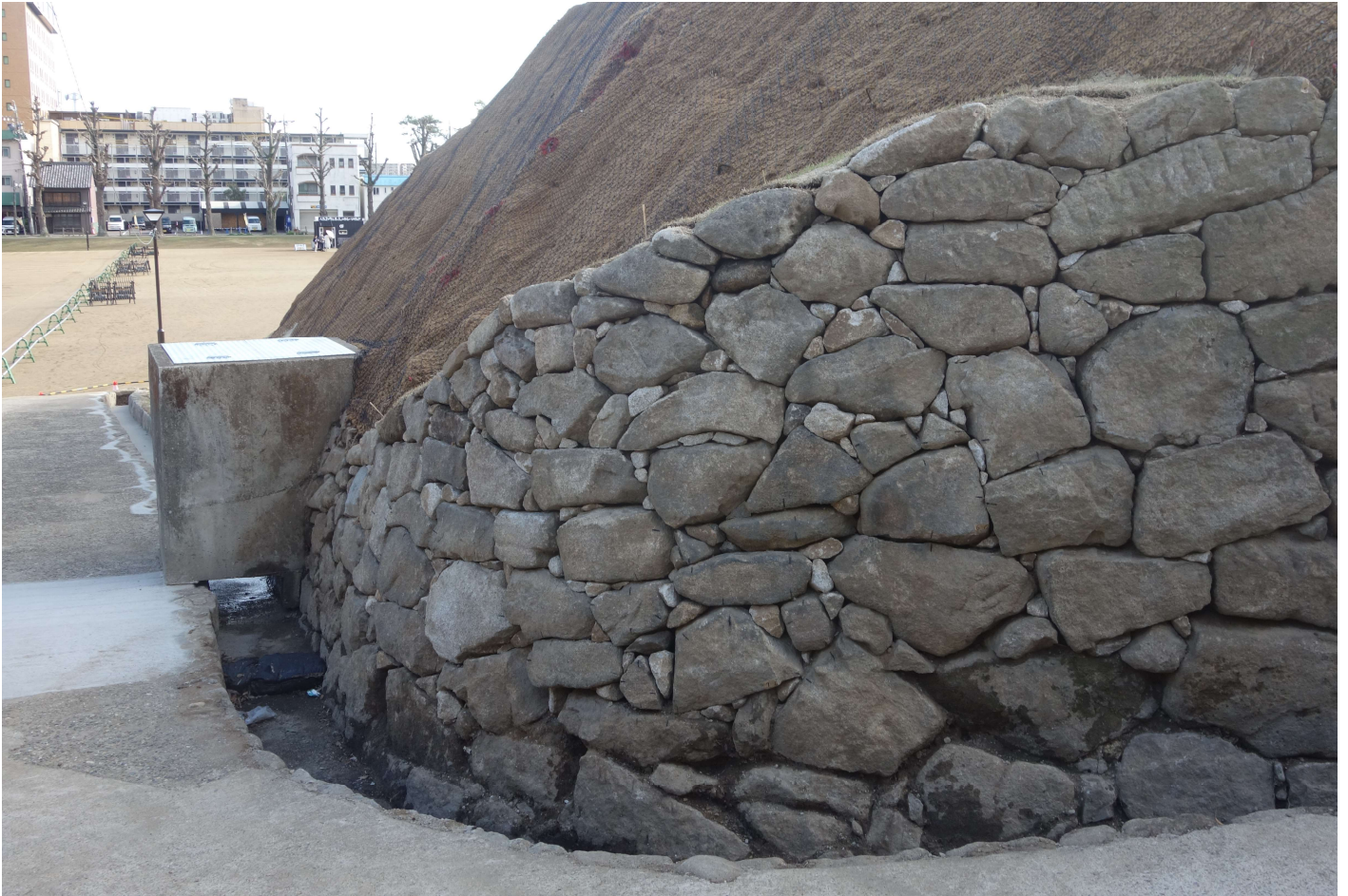
写真1 修復完了後の南切通し西面石垣（北から撮影）
