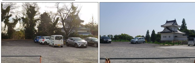
写真 16 南切通し東側法面の樹木伐採前（左）・後（右）
