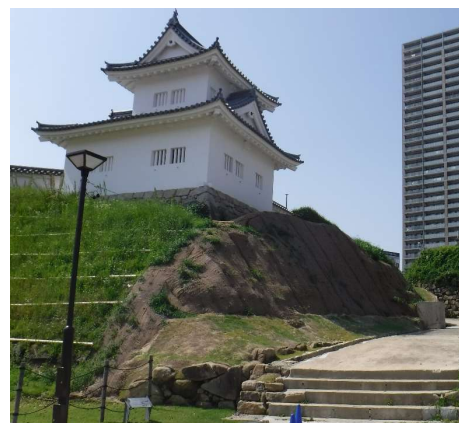
写真12 西側斜面修復完了(南から撮影)
