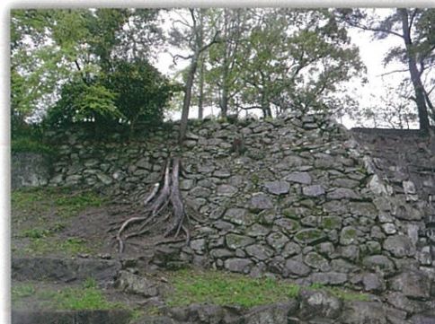
⑫ 南切通し石垣 □ 堀底を道として利用したもので、S字状に曲がります。東隅櫓からの横矢がかかる(敵の側面から矢を射る)構造となっています。
