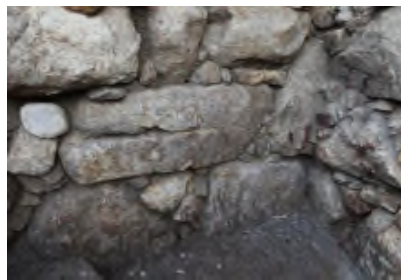
写真5 No. ③石垣 入隅部
