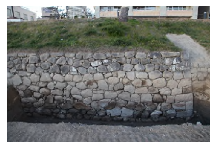
写真12 No. ⑥東側石垣
