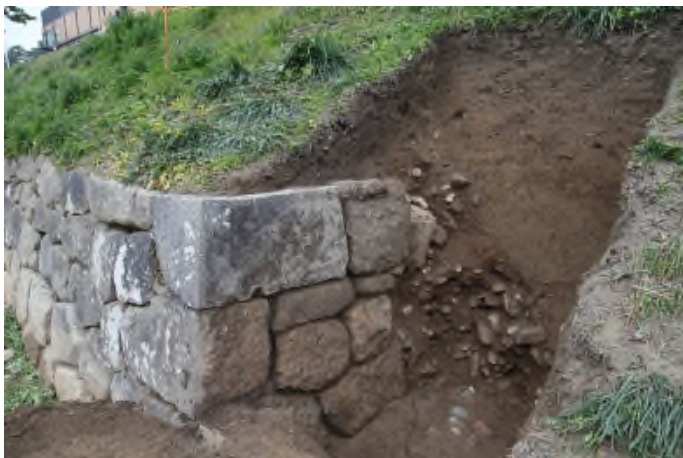
写真7 No. ⑤石垣（隅部の折れ） 一部崩落により裏込め石が流出
