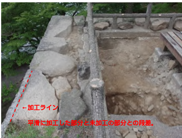
写真3 櫓台石垣の加工痕跡（東から） 土台木を載せるために石垣を平滑に加工している
