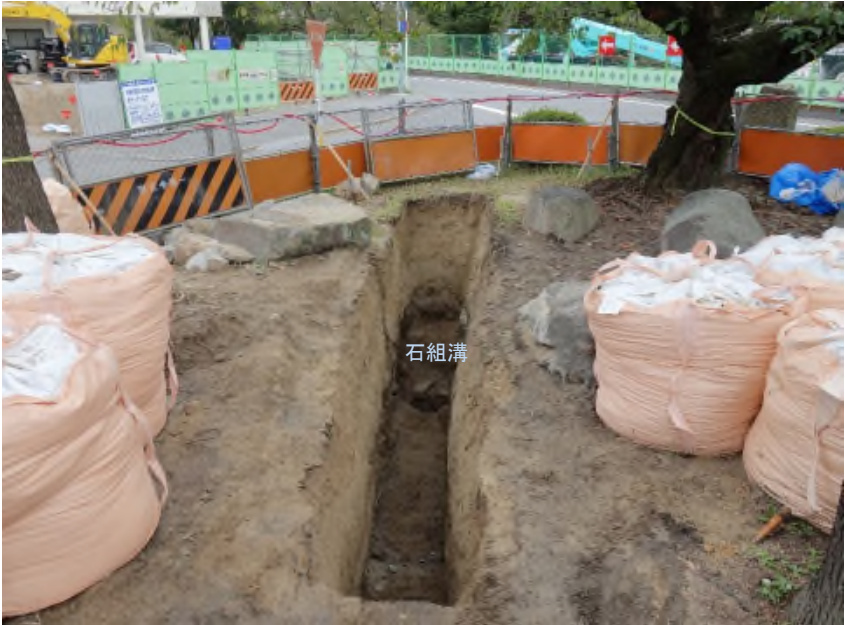
T-2 現代の石組溝と花崗岩片の埋め立て土（北西から）
