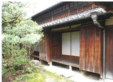
主屋（南東側から）
