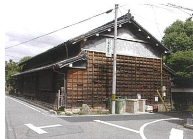
主屋（西側から）
