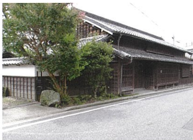
主屋（北東側から）
