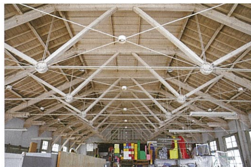
木材と鋼材の混構造トラス
