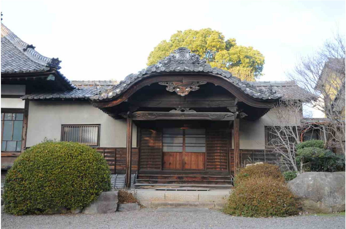
玄関 外観 南より（岡崎市教委提供）
