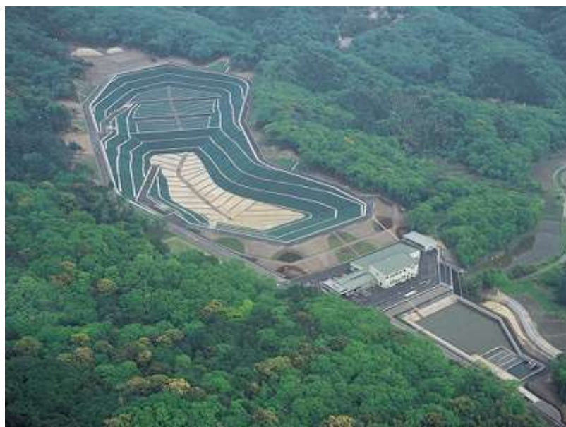
北部一般廃棄物最終処分場
