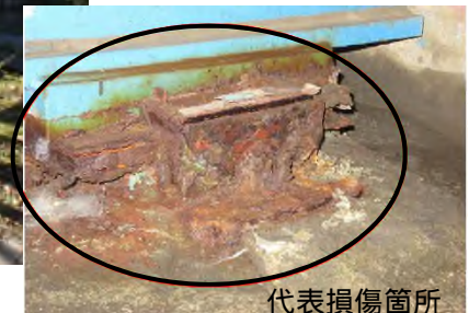
令和4年度修繕予定 長沢連橋(中金町)
