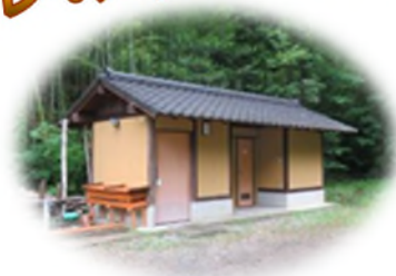
施設唯一の便所 (循環式)
