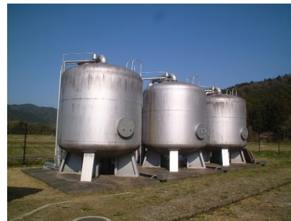
額田南部浄水場水処理設備（急速ろ過機）
