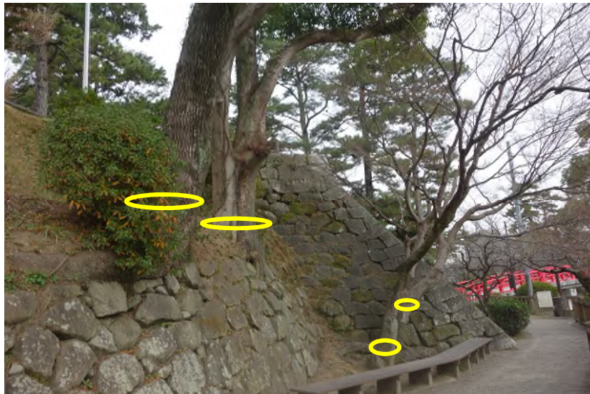
石垣を毀損する樹木の伐採
