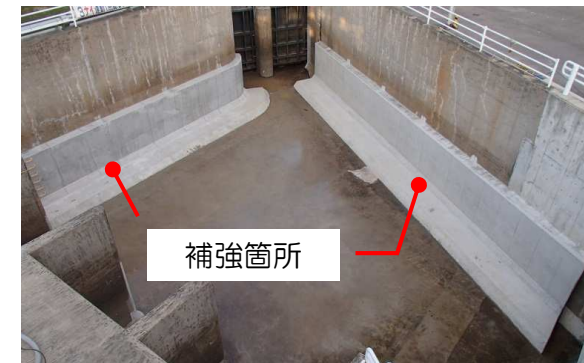
壁・底版などのコンクリート増し打ち状況
