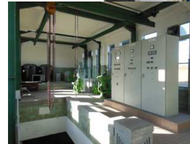
本宿配水場電気室（現況）
