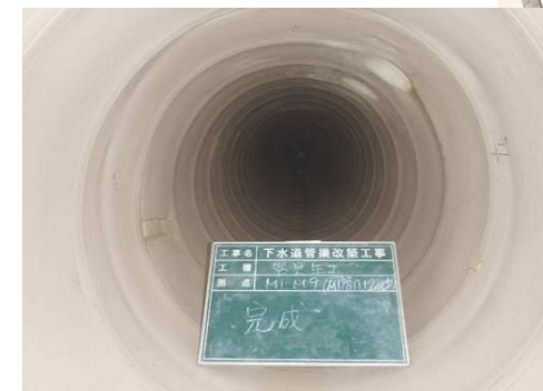
改築更新された下水道管
