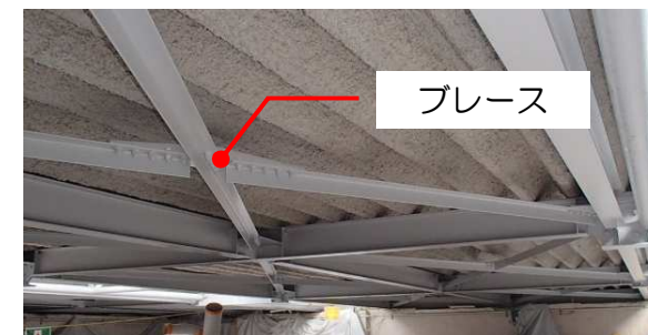
天井へのブレース（筋交い）設置状況
