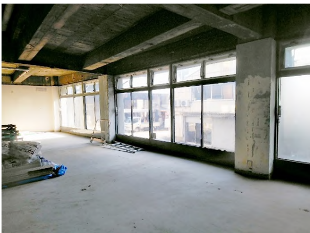
内部（工事中）①
