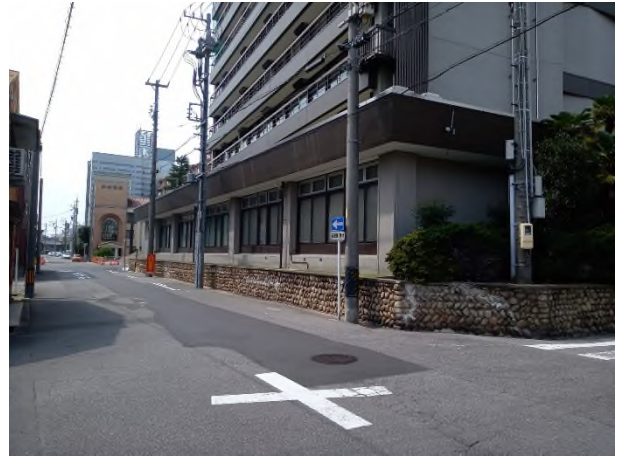
南東から建物
