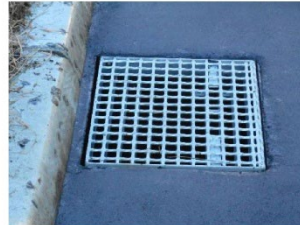
写真Ⅱ-3 グレーチング蓋の格子の形状等を工夫した事例
