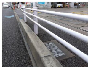
写真Ⅱ-2 歩道上の施設幅内に集水ますを移設した事例
