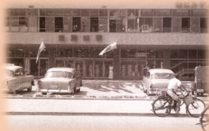
東岡崎駅 新駅舎 竣工
