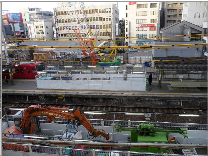
バリアフリー化設備工事写真 ( H22.1.14 現在 )
