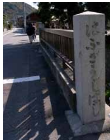
法蔵寺橋高欄の修景整備
