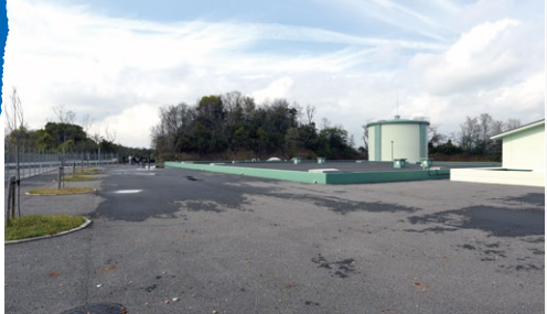
6 大西配水場拡張工事完了
