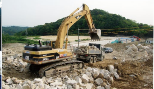
順調に造成工事が進められた「エコロタウンとさわ南」
