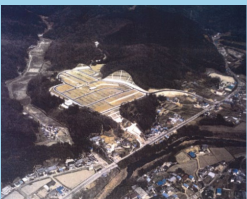
山地を切り開く大規模な造成工事が行われた
