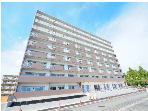
改築された市営大樹寺住宅
