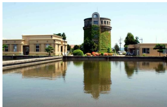
【廃止前の六供浄水場】
